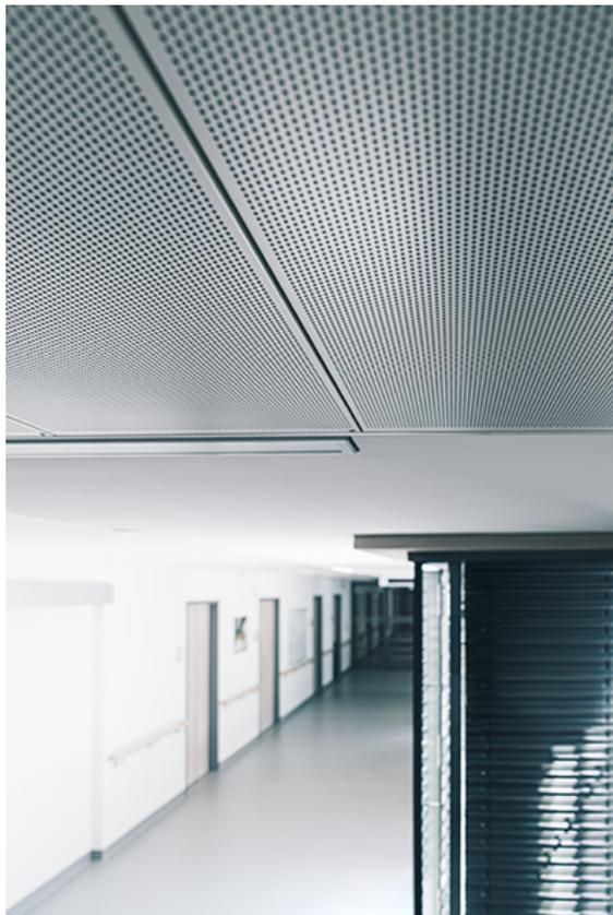
Besonderen Wert legte man im Bezirksklinikum Mainkofen auf eine effiziente und komfortable Ausführung der **Brandschutzdecken EI 30**. Die abklappbaren Brandschutzdecken sind in Perforation 320v ausgeführt und sorgen in den hochfrequentierten Bereichen für sehr gute Raumakustik. LED-Lichtbänder Typ **Fural Aluline** überzeugen mit optimaler Beleuchtung und hochwertigem Design.
