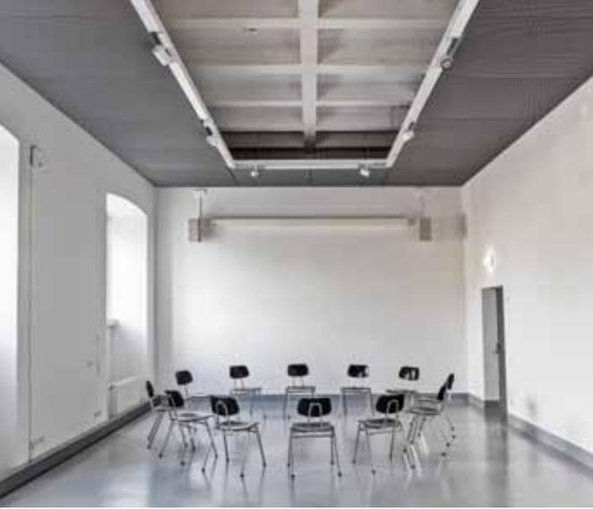
**SEMINARRAUM.** Die Rohdecke ist als Rippenkonstruktion ausgeführt, welche erhalten bleiben sollte.
