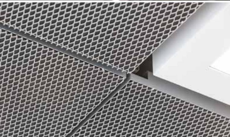
Prämisse ebenso einzuhalten. Die Rohdecke ist als Rippenkonstruktion ausgeführt, welche bleiben sollte. Dennoch mussten die Gebäude raumakustisch an die Ansprüche eines modernen Universitätsbetriebs angepasst werden. Die Lösung war eine an den Wandbereichen umlaufend angebrachte Streckmetalldecke. Der Charakter des Streckmetalls ergänzt das Erscheinungsbild des historischen Gebäudes in optimaler Weise.
