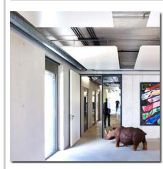
Präzise gefertigte Deckensegel mit **45°-Kantungen** setzen stilistische Akzente in der neuen Firmenzentrale des Fahrzeugentwicklers GOTECH in Weissach. Purismus und Funktionalität prägen die Innenarchitektur.
