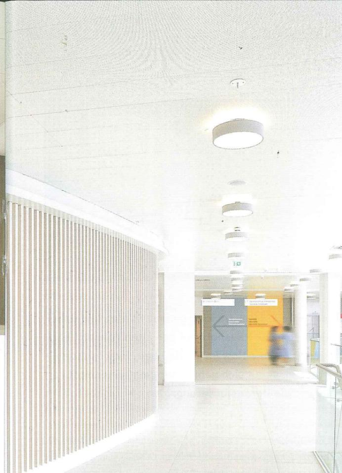
Wandanschluss mit Schattenfederleisten 20/20. Je nach Raum variiert die Modulbreite zwischen 300, 400 und 500 mm. Die Hauptlängen sind Kassetten mit 2.000 bzw. 2.500 mm.
