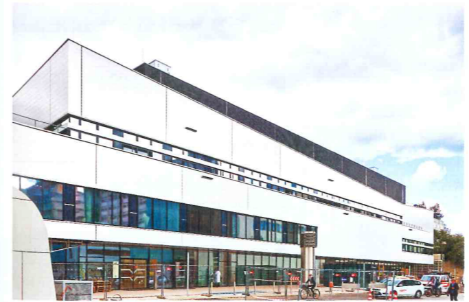
Anbau. Der Neubau des Versorgungszentrums bildet den vorläufigen Schlusspunkt der Baumaßnahmen am Uniklinikum Graz.
