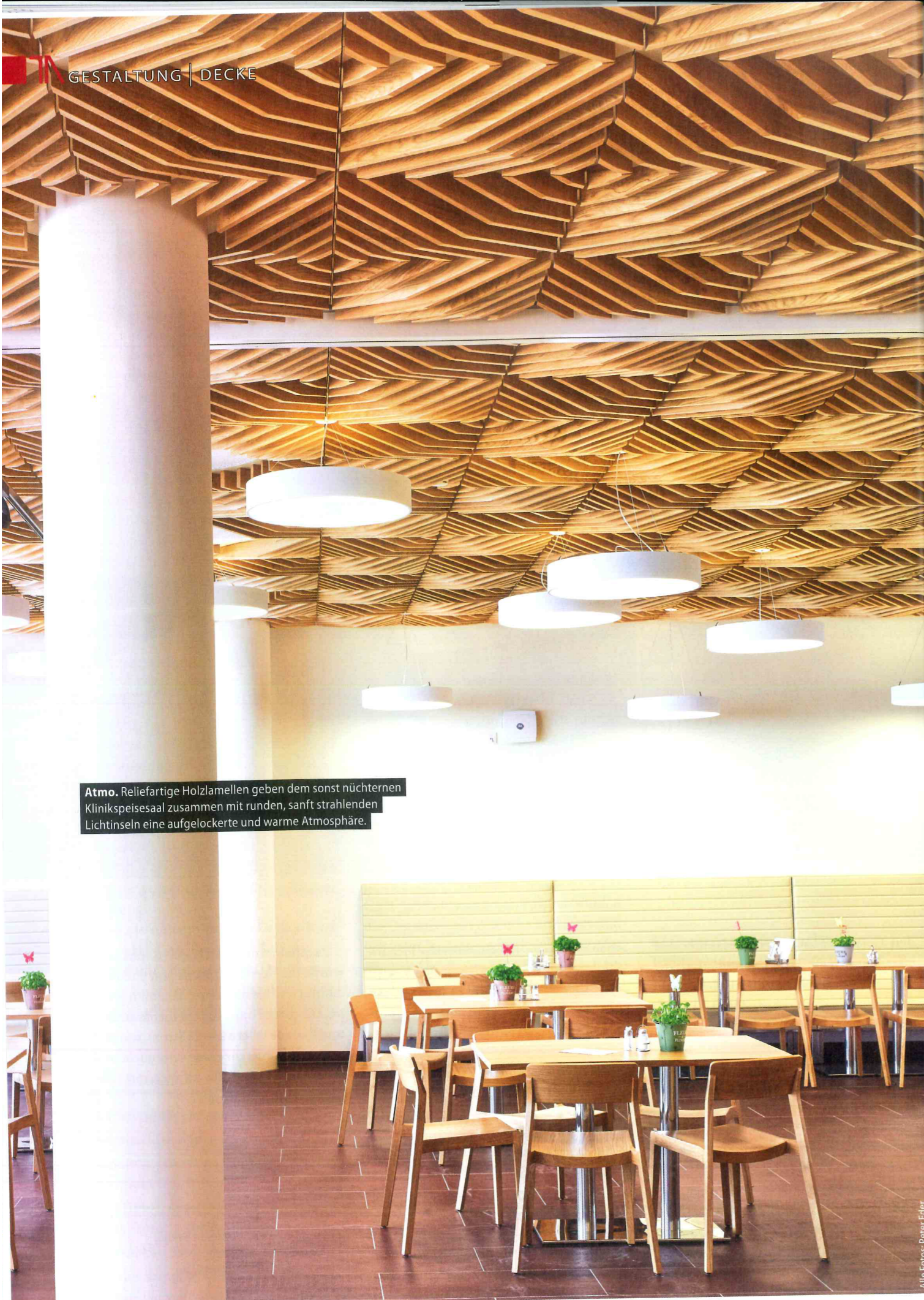
Hybrid. Die Metallkassetten sind 632 x 632 mm groß, verlegt mit einer umlaufenden Fuge von 3 mm. Die Lamellen sind durch die Kassetten hindurch verschraubt. Die Lamellen sind 20 mm breit und von den Enden her von 38 mm zur Mitte hin auf 95 mm ansteigend.
