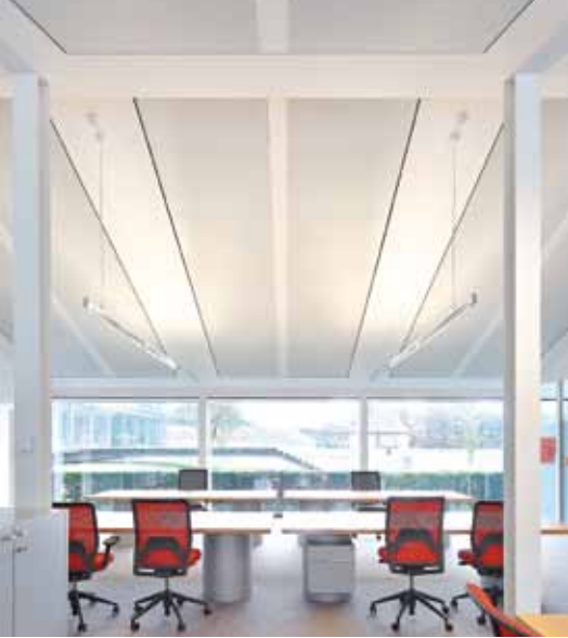
PLUSPUNKT. Die Temperierung der Räume erfolgt ebenfalls über die Decke.
