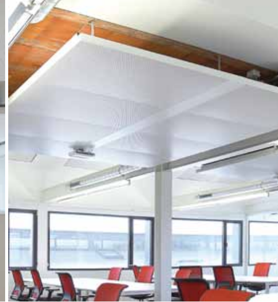
DECKENSEGEL. In den unteren Geschossen wurde die Rohdecke durch markante Betonüberlager ausgebildet, einige Bereiche sind mit rohen Ziegeldecken ausgestattet.
