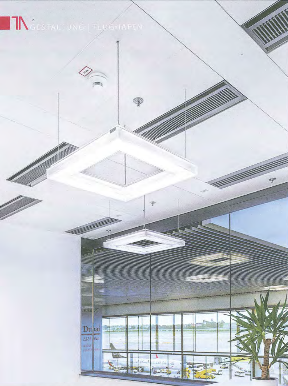
Ausgleich über Bandraster. Der Ausgleich zwischen gebogenem Gebäude und rechtwinkligen Kassetten geschieht über konische Bandraster.
