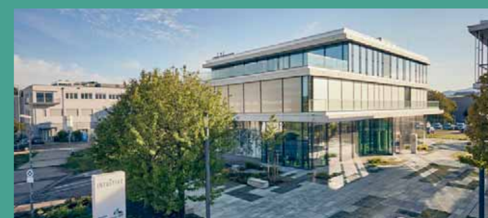
→ Intuitive Surgical Deutschland Freiburg, DE stropní ostrůvky
