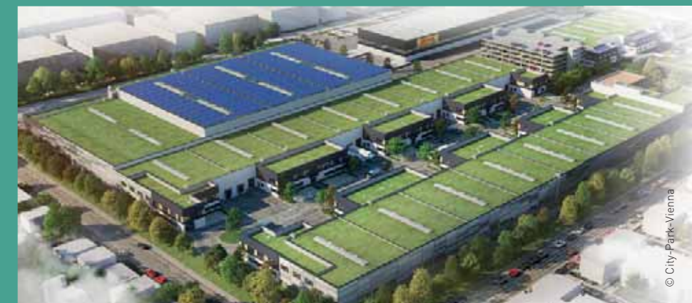
→ City Park Viedeň, AT chladicí podhled
